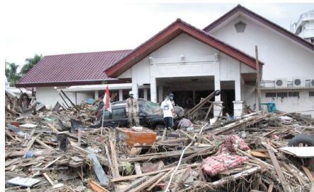
Καταστροφή από το Ασιατικό τσουνάμι (Ινδονησία) 26 Δεκεμβρίου 2004.
