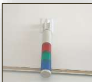
Εικόνα 203. Φωτοσήμανση σε τρία διαφορετικά χρώματα που ανάβουν για να ειδοποιήσουν και να υποδείξουν διαφορετικές καταστάσεις (π.χ. διάλειμμα, συναγερμός, κ.α.) (Rocky Mountain Deaf School, Denver, USA)
