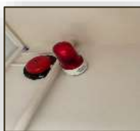
Εικόνα 204. Περιστρεφόμενη λάμπα διαδρόμου φωτεινής ειδοποίησης (Ειδικό Λύκειο Κωφών & Βαρηκόνων Αγίας Παρασκευής)
