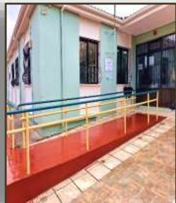
Εικόνα 63. Ράμπα από ομοιογενές, σταθερό υλικό (Ειδικό Δημοτικό σχολείο Δράμας)
