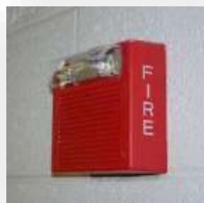
Εικόνα 62. Σύστημα ειδοποίησης πυρκαγιάς (Δημουλά, κ.ά., 2023)
