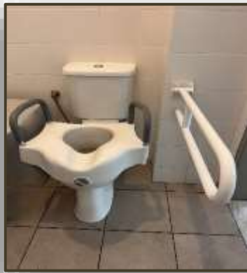
Εικόνα 176. Προσβάσιμος χώρος υγιεινής (Ε.Ε.Ε.ΕΚ. Ελευσίνας)
