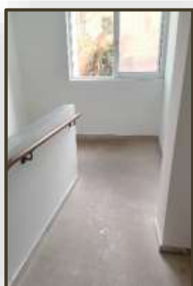
Εικόνα 54. Επικλινής διάδρομος με μπάρα στήριξης (1 ο Ειδικό Δημοτικό σχολείο Χανίων)
