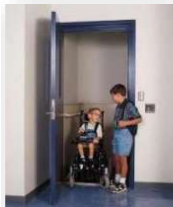
Εικόνα 102. Οριζόντια χειρολαβή σε θύρα αίθουσας σχολείου (Δημουλά, κ.ά., 2023)
