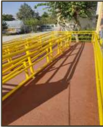
Εικόνα 61. Ράμπα από αντιολισθητικό υλικό (Ε.Ε.Ε.ΕΚ. Βόλου)
