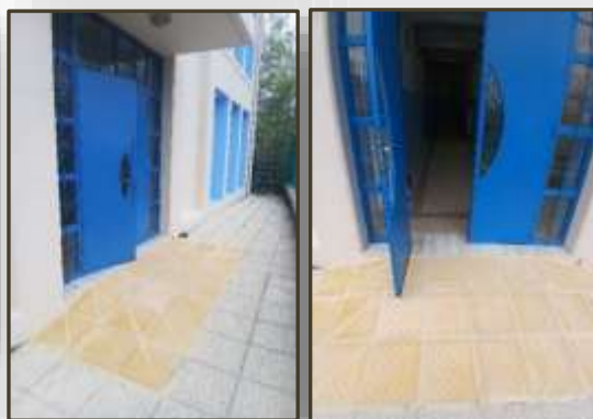
Εικόνα 5. Είσοδος σχολείου με φεγγίτη (1 ο Δημοτικό σχολείο Σουφλίου)
