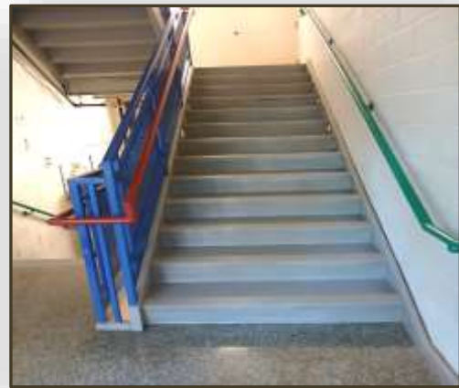
Εικόνες 73 & 74. Κλιμακοστάσιο - Χρωματική αντίθεση χειρολισθήρων (National Child Research Center Preschool, Washington, DC, USA)
