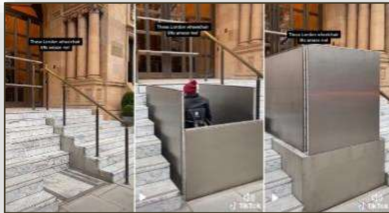
Εικόνα 20. Αναβατόριο με πλατφόρμα βυθιζόμενη στο πεζοδρόμιο, για πρόσβαση στην είσοδο (Δημουλά, κ.ά., 2023)
